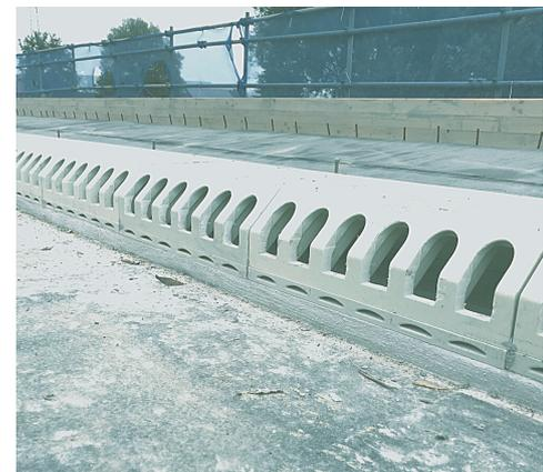
Bridge Drainage Einheiten von der Fahrbahn
