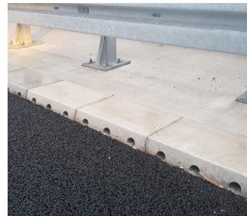
Bridge Drainage units vanaf het wegdek
