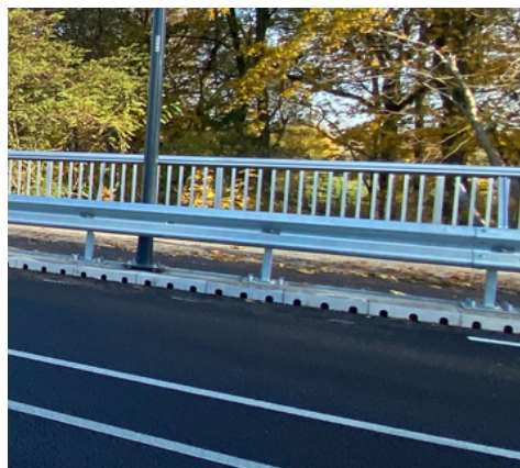
Bridge Drainage op locatie
